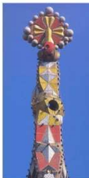
2. En la torres de la Sagrada Família hay un impresionante despliegue geométrico poliédrico de una gran complejidad, a base de maclas (intersecciones) de diversos cuerpos geométricos poliédricos.
