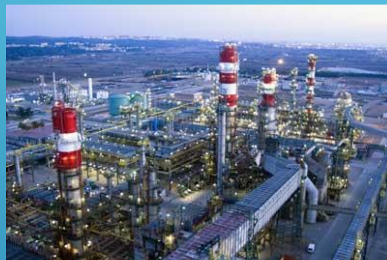
Petroquímica de Tarragona
