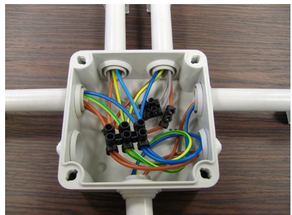
Figura 1.22. Pelado correcto del cable conectado a un borne en una regleta.
