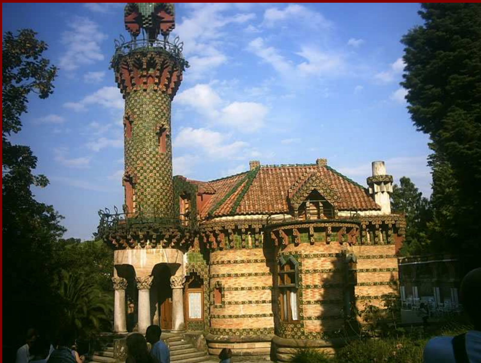
1883, El Capricho. Edifici del marquès de Comillas a Santander
