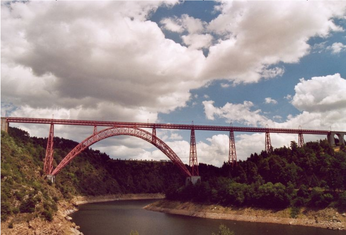
Viaducte de Garabit, 1884
