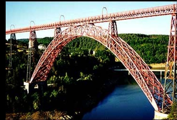
Viaducte de Garabit França 1884
